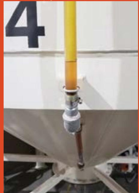
**Figura 6.** Ejemplo de la configuración de llenado inferior para tanques de almacenamiento de grasas y aceites. (Fuente: J.P. Burkhalter. 1976. J. Amer. Oil Chem. Soc., 53:332-333.)
